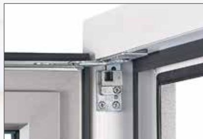
Scherenbeschlag oben
