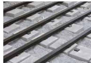
WPC-Unterkonstruktion auf Gummipads
